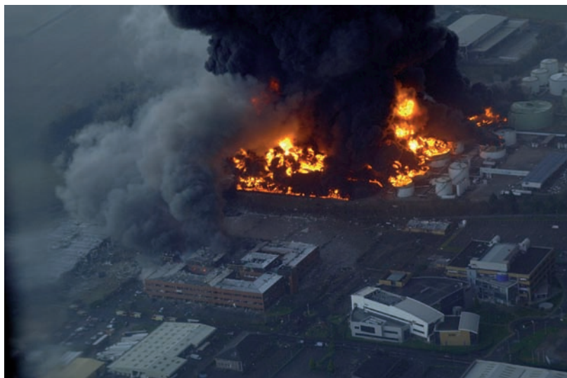
Bild 2: Im Dezember 2005 kam es im englischen Tanklager Buncefield nach Freisetzung einer großen Ottokraftstoffdampf-Wolke zu mehreren Explosionen und einem verheerenden Folgebrand (Quelle: www.buncefieldinvestigation.gov.uk ).
